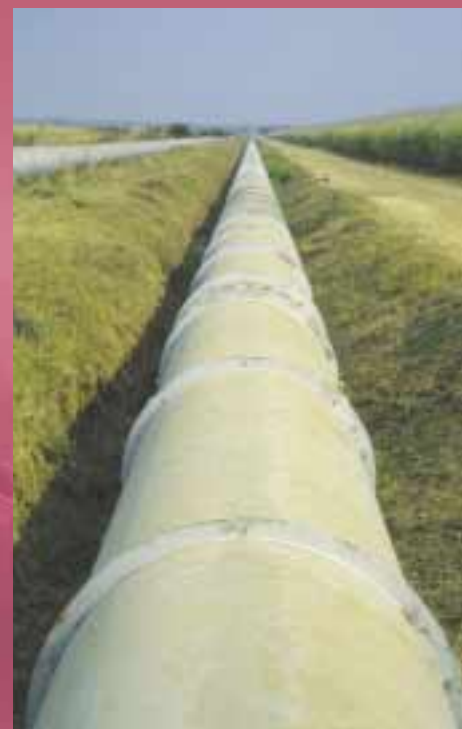
Kafue Flats, Zambia. Water supply (from the Kafue River) to sugar cane fields
