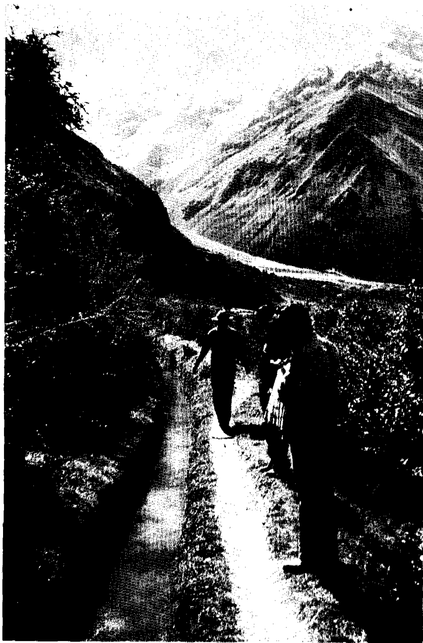
Tramo intacto del canal La Estrella
