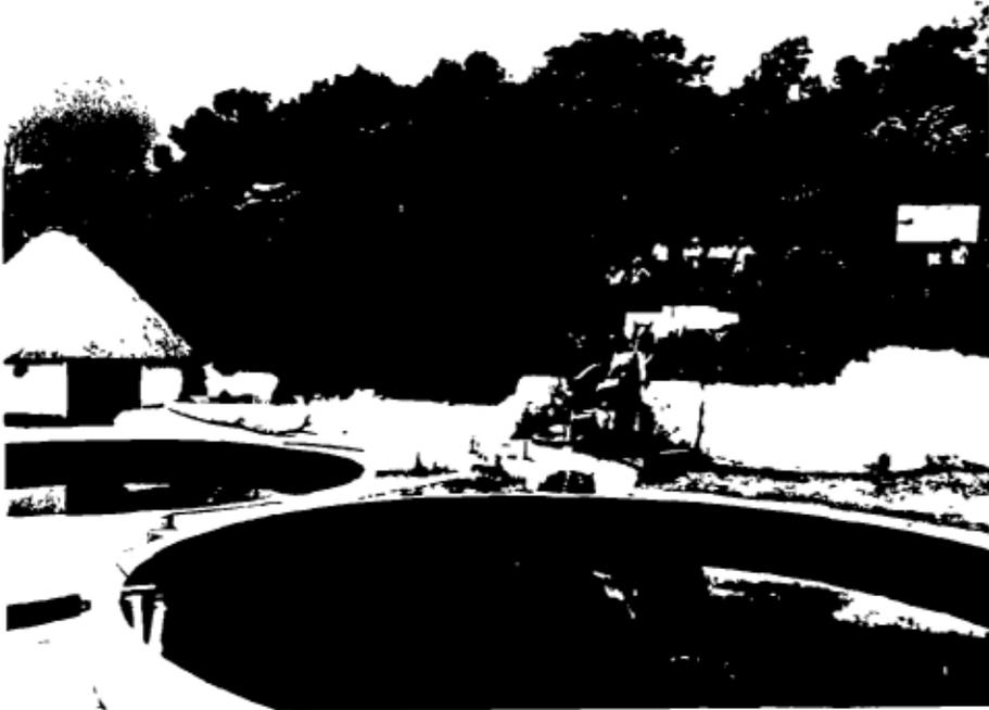
La planta de tratamiento esta compuesta por dos modulos independientes de filtración lenta en arena y un tanque de dosificación de cloro en la etapa final del proceso. (Ver Figura No.2).
