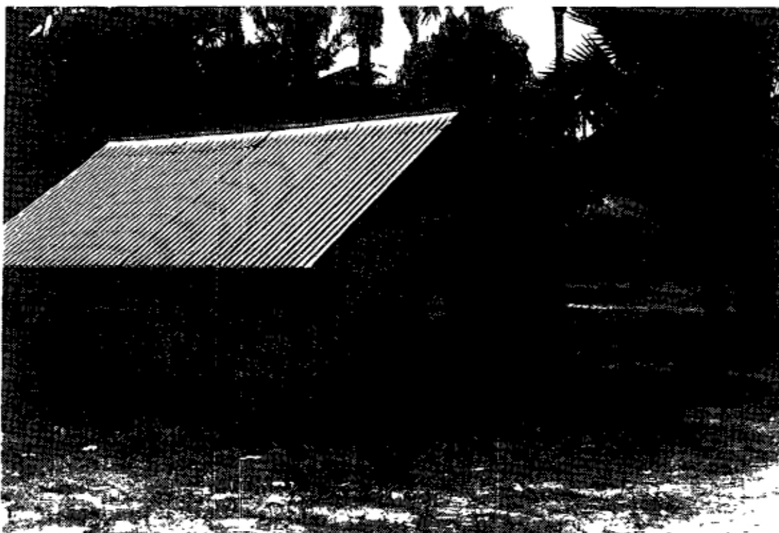
Instalações sanitárias abatidas.
