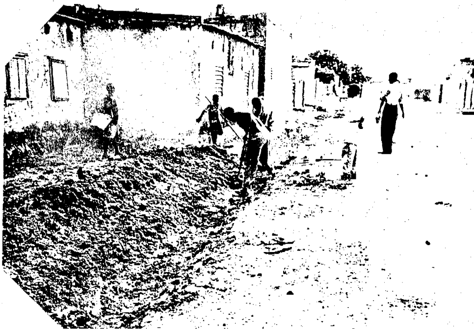
Dans certaines rues, on en a profité pour creuser les caniveaux envahis par la terre.
