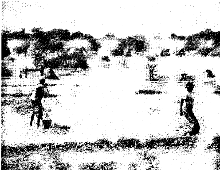
L'installation des diguettes (ici en terre) comme mesure de conservation des eaux et des sols a pris un grand essor.
