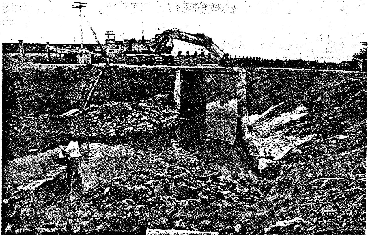
La falta de alcantarillado y las descargas de aguas negras, sin ningún tratamiento, a los esteros El
